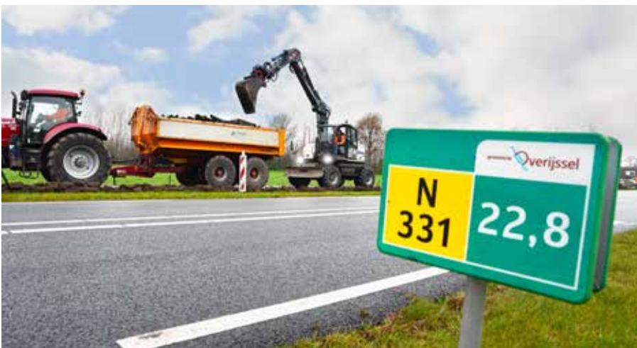
Het gebruik van cementloze verharding vermindert de CO 2 -uitstoot.
