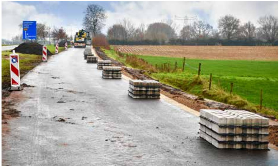
De provincie Overijssel heeft langs de N331 een proefvak gemaakt met cementloze bermverharding.
